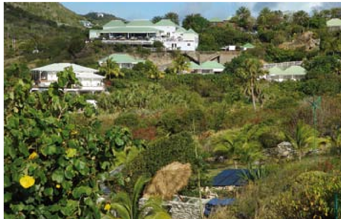
Saint-Barthélemy - Hôtel Le Toiny Maisons sur la plage, éclairage du site avec énergie autonome
